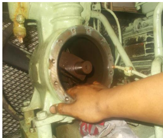
Gambar 5. Pengantian Piston
